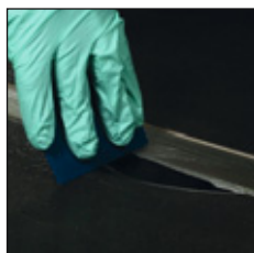
10. Glätten Sie die Masse sofort und lassen Sie sie ungefähr 60 Minuten aushärten.
